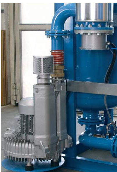
Figure: Detail „Ventilation Unit“
